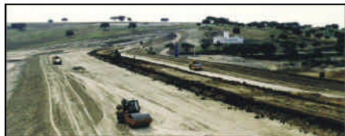
Fase de construção
