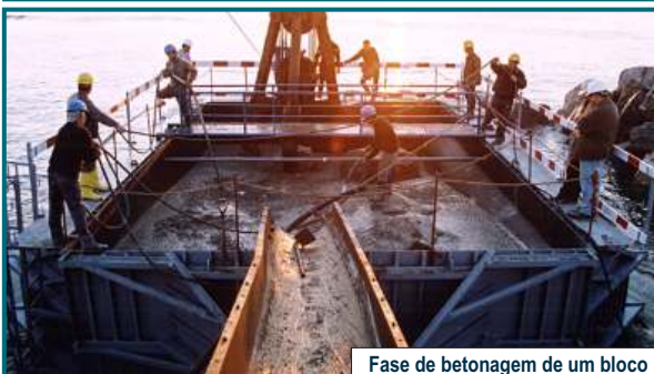
Fase de betonagem de um bloco
