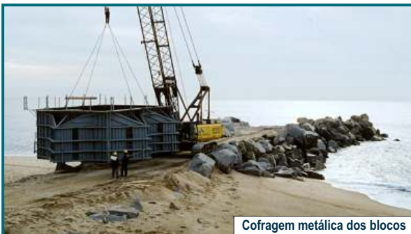
Cofragem metálica dos blocos
